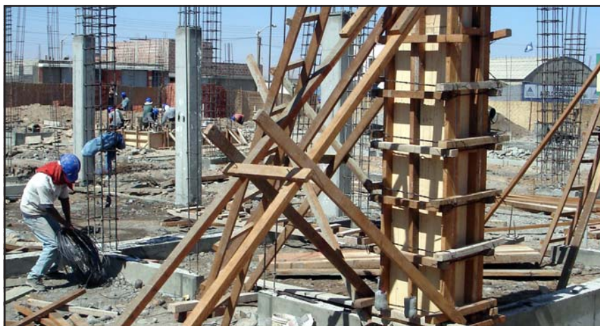
Módulo Básico de Justicia en construcción, en la ciudad de Tacna
