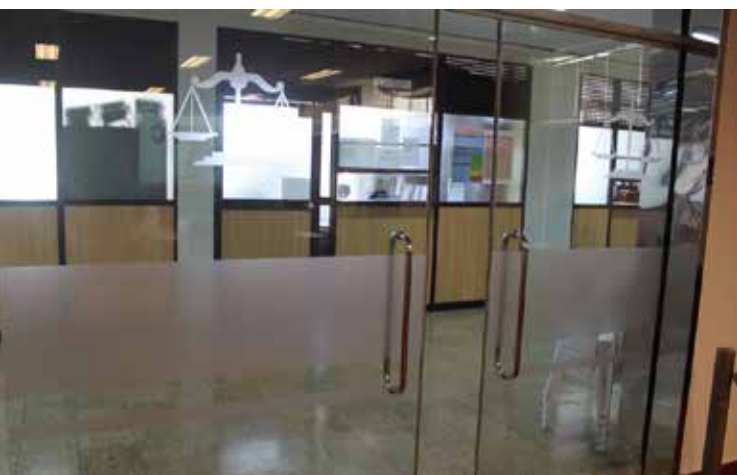
Mejora del Auditorio con manpara de vidrio
